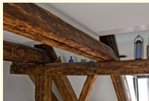
Ausgebautes Dachgeschoss mit mittelalterlichem Dachstuhl
