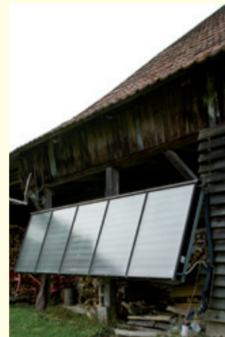
Schwenkbarer Solarkollektor, der eine optimale Ausbeutung der Sonnenenergie ermöglicht.
