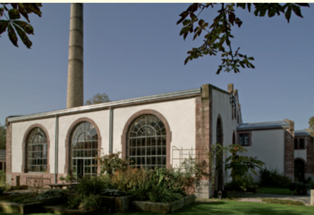
Südostfassade mit Metallrundbogenfenstern und Sandsteineinfassungen
