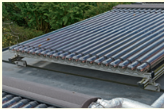
Vakuümrohrenkollektor
