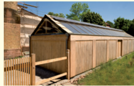
Nebengebäude eignen sich gut für die Anbringung von Solaranlagen. Bei Neubauten können sie Teil der Architektur sein.
