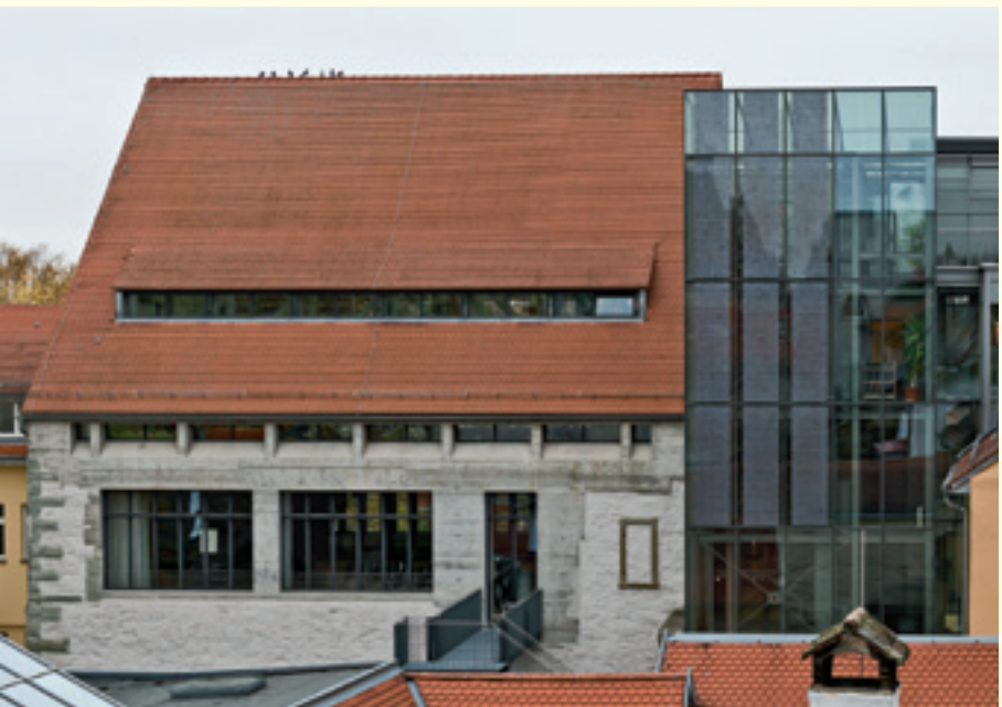
Semitransparente Photovoltaikanlage im neu errichteten Erschließungsturm im nicht einsehbaren Innenhofbereich
