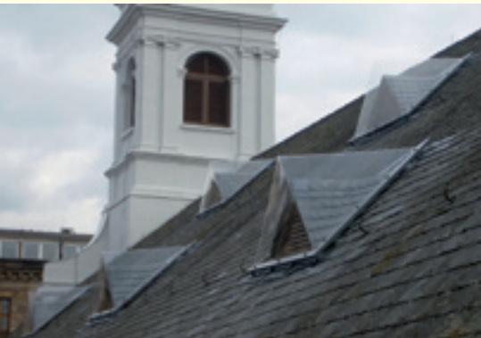
Luftkollektoren über den Dreiecksgauben der Süddachfläche
