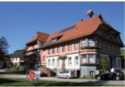
Kleine Kollektorflächen als Indachanlagen erleichtern die Einbindung in das Erscheinungsbild eines Gebäudes.
