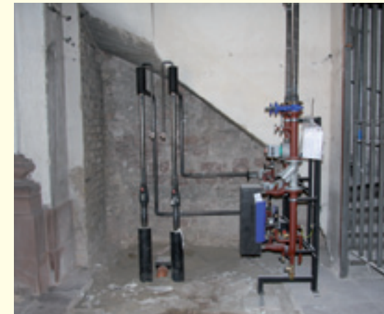
4 Fernwärmeübergabe unter der Empore
